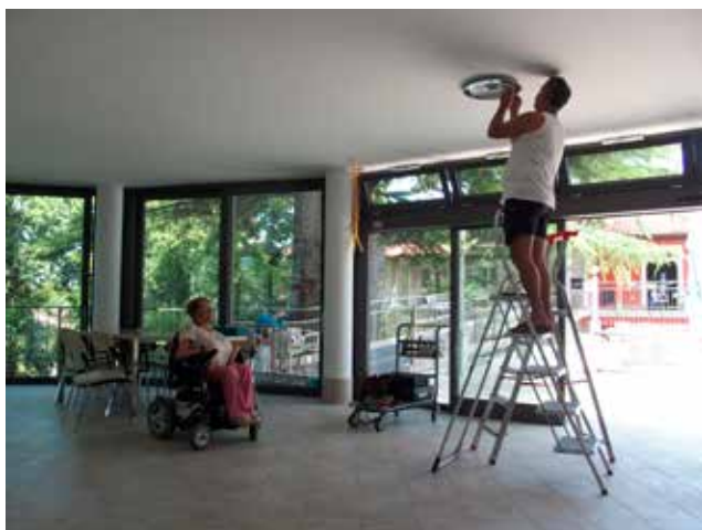
Tekoča vzdrževalna dela v Domu dva topola.
