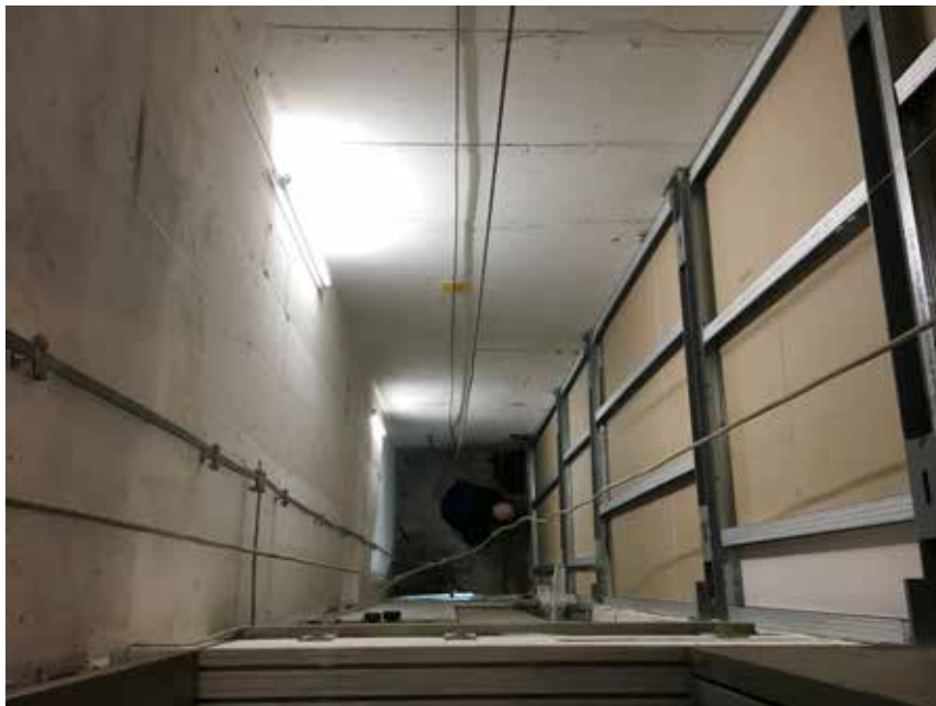
Prva faza zamenjave dvigal že poteka
