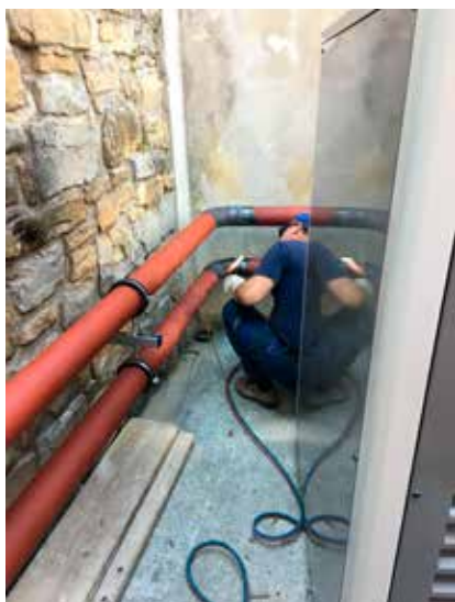
Varjenje cevi pri toplotnih črpalkah.
