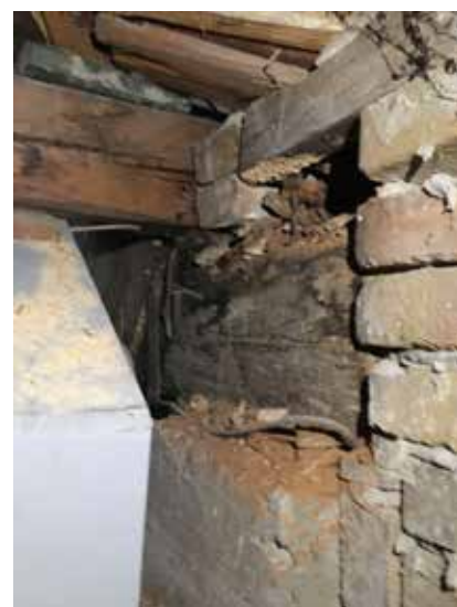
Preperel del lesenega nosilca strehe.
