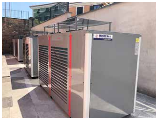
Končna postavitev štirih toplotnih črpalk v Domu dva topola d.o.o.
