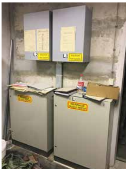
Elektro omare v strojnici starih dvigal v fazi demontaže.
