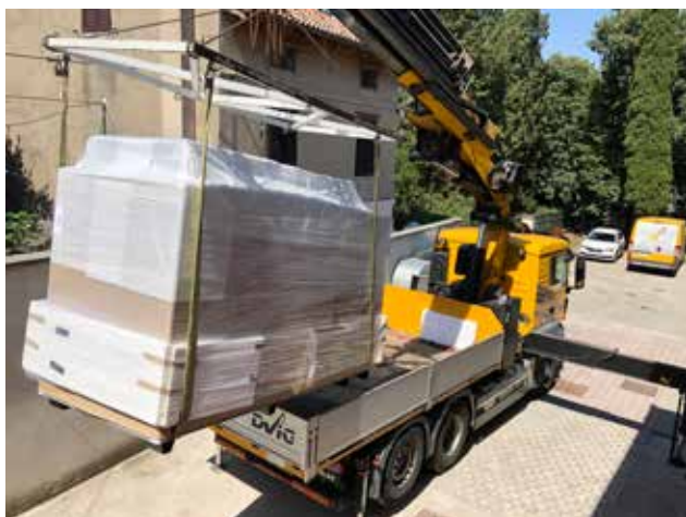
Dvig klimatov v Domu dva topola d.o.o.
