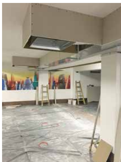
Obdelava prezračevalnih kanalov z mavčnimi ploščami v restavraciji.
