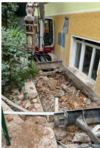
Prilagoditvena dela za hidroizolacijo objekta
