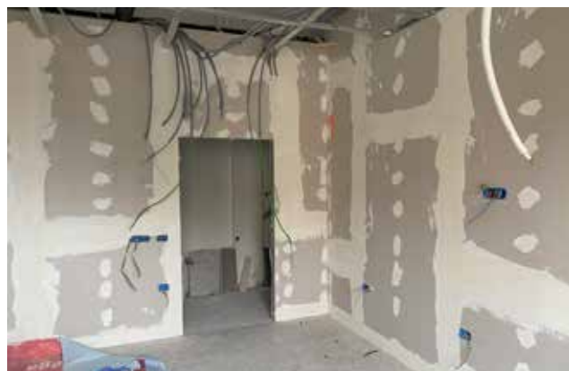
Montaža mavčnih plošč v eni od sob in vgradnja električne napeljave
