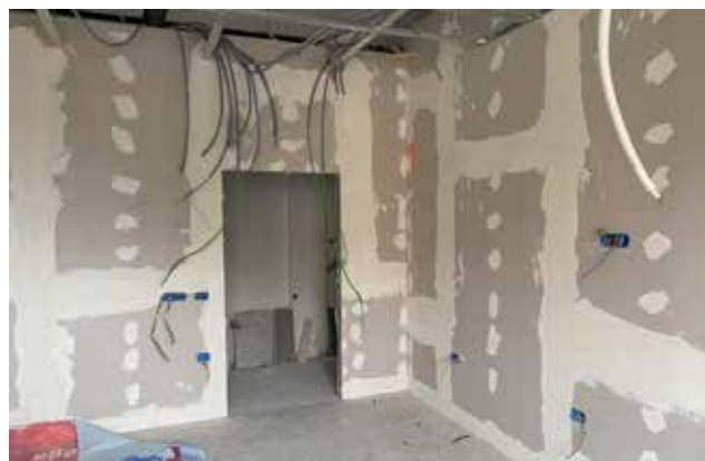
Montaža mavčnih plošč v eni od sob in vgradnja električne napeljave
