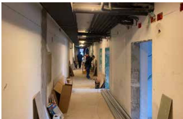
Razširjena ekipa delavcev pri montaži strojnih inštalacij
