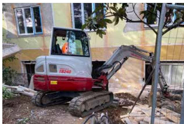
Zgoraj vgrajena nova okna, spodaj izkop za hidroizolacijo stavbe
