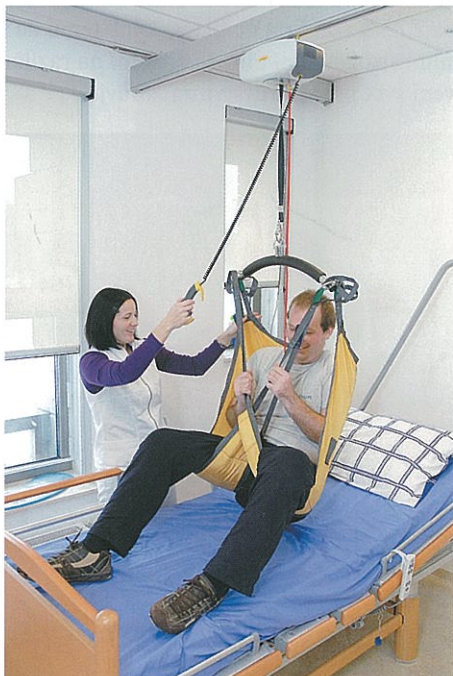
Slika 19: Stropno dvigalo: viden je sistem dvojnih vodil na stropu, eno vodilo potuje po drugem in elektromotor po spodnjem vodilu, kar omogoča pomikanje invalida v vse smeri: naprej, nazaj, levo, desno.
