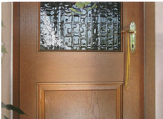
Slika 64: Trak, kot podaljšek na kljuki, ki distrofik na vozičku omogoča enostavno odpiranje vrat.
