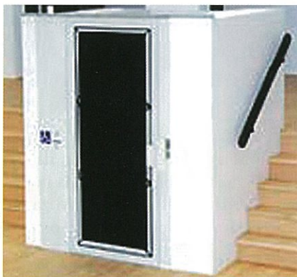
Slika 16: Hišno (zaprto) dvigalo.
