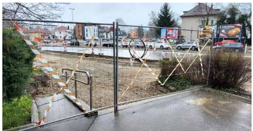
Priprava gradbišča za izgradnjo parkirnih mest za invalide
